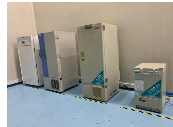
Capacidad actual instalada de ultracongelación
