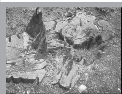
Zonas negruzcas indican condición de Podredumbre encontrada en fustes y bases de los cipreses de gran porte. Inminente peligro de volcamiento.
