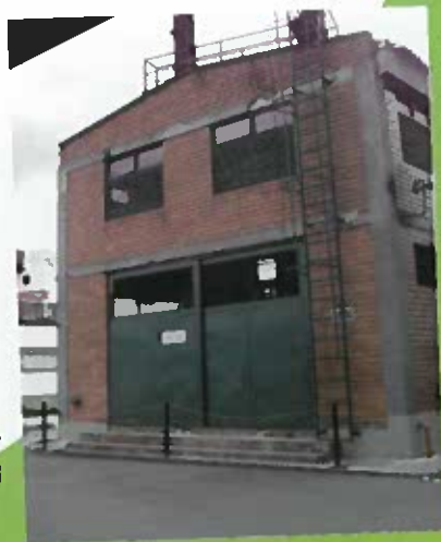
Fachada de las calderas
